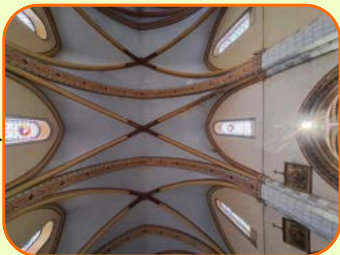
Réfection des plâtres de la voûte terminée.
